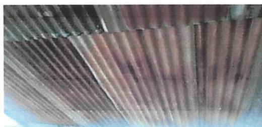
Foto 2: CUBIERTA DE LAMINA
