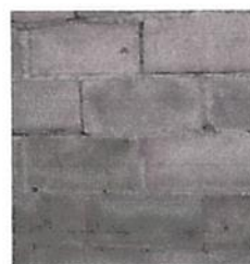
Foto 6: REPARACIÓN DE REPELLO Y CERNIDO DE PAREDES
