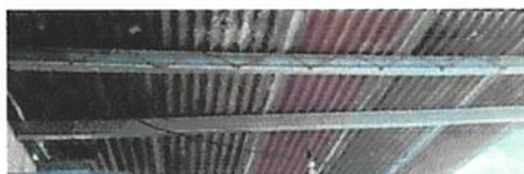
Foto 1: ESTRUCTURA DE TECHO
