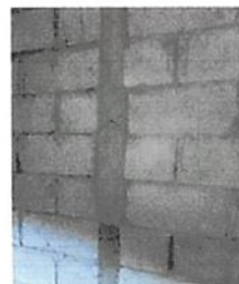
Foto 4: REPARACIÓN DE MUROS
